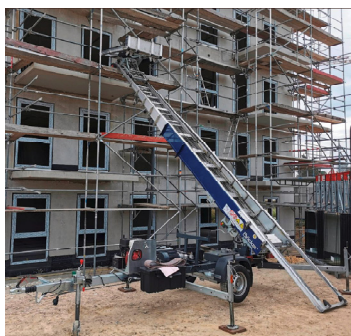
Bauaufzug Junior befördert Fenster effizient in die Höhe
