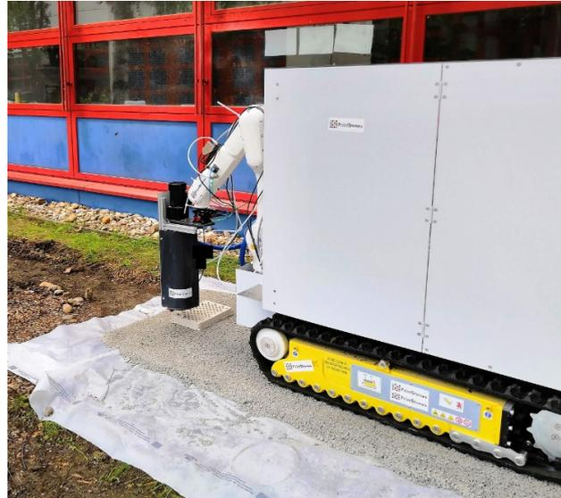
ausgearbeiteten Sichtschutz platzieren würden, den maßgeschneiderten Gehweg easy verlegen ließen und bei all dem auch noch CO<sub>2</sub> reduzieren würden? Wie das gehen soll, weiß das Start-up PrintStones: Mit seinem mobilen 3D-Drucker lassen sich individuelle Betonteile vor Ort auf der Baustelle erstellen. Für die nötige Flexibilität sorgt ein aus der Industrieautomation bekanntes Werkzeugwechselsystem von Gimatic.
