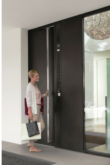
Das Schüco Door Control System beinhaltet vielfältige Anmelde-möglichkeiten der Zutrittskontrolle und Türkommunikation.
