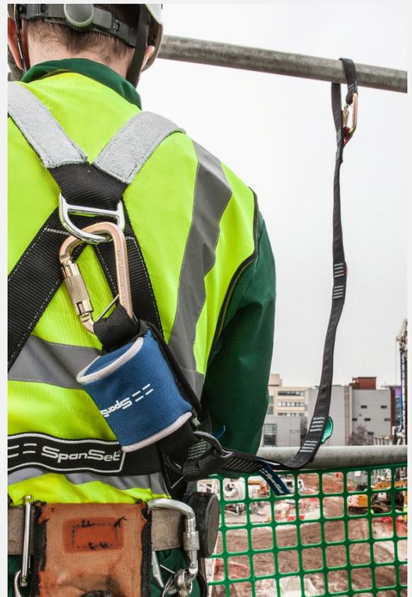
Das SP-140 ist speziell für kurze Fallstrecken und hohes Körpergewicht konzipiert.
