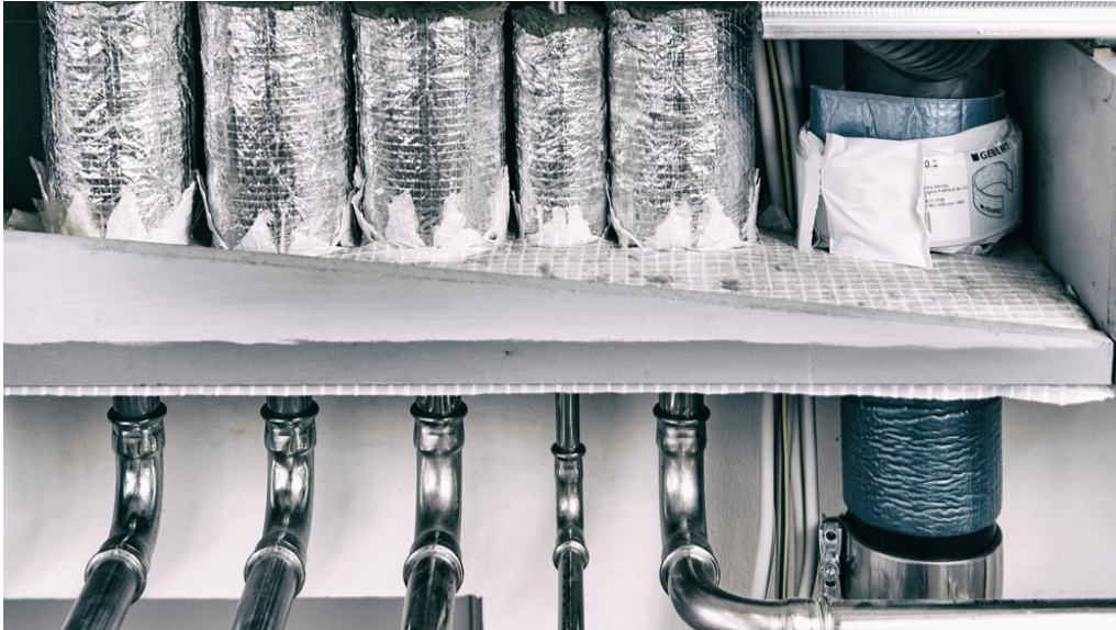
Detailansicht Rohrdurchführung durch die Kellerdecke in den Geberit Quattro Installationsschacht mit Geberit Deckenverschluss System FSH 90 und Medienleitungen mit Minimalabständen (TW und Elektro = Nullabstand und AW = 20 mm Abstand) – ohne das klassifizierte Abschottungen R 90/ S 90 notwendig sind.
