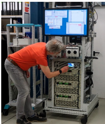
KIT auf den Messen Intersolar und ees: Intelligentes Energiesystem der Zukunft – Forschungsinfrastruktur Energy Lab 2.0
