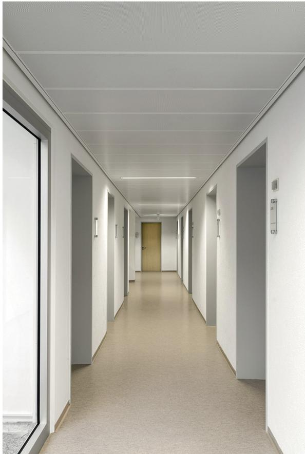
Ein schneller Zugang zum Brandherd im Deckenhohlraum ist für Feuerwehren im Falle eines Brandes von größter Bedeutung, um Leben zu retten. Die neu entwickelte selbstständige F30 Brandschutzunterdecke ermöglicht den entscheidenden Vorteil für Alarmzugang bei einem Feuerwehreinsatz: Die Deckenelemente sind durch einfaches Antippen schnell zu Öffnen und zu Schließen – ohne den Einsatz von Werkzeugen.
