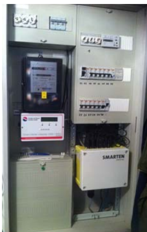
SMARTFOX als Festeinbau Bild: SMARTEN
