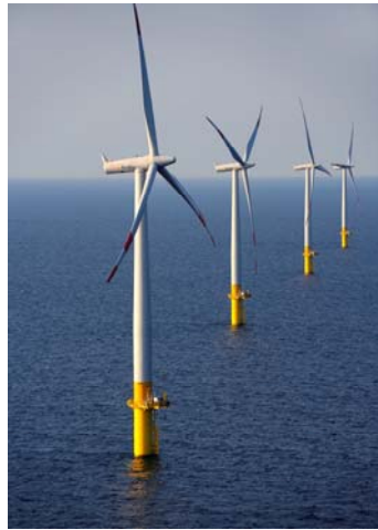
EnBW Baltic 1: Vom Fundament bis zur Flügelspitze messen die Windenergieanlagen rund 115 Meter.
